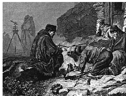
Vermessung im Gelände
